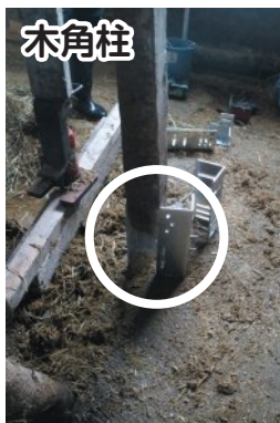
図1 腐食により浮いている
