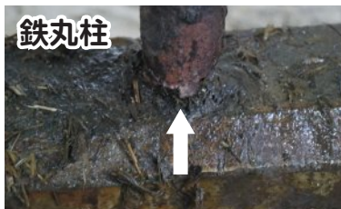
図1 腐食により浮いている
