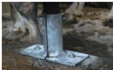
図2 固定具で挟みボルト固定
